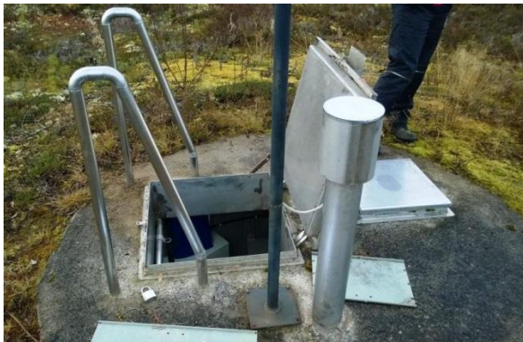
Kuva 2. Vedenottamon kansirakenteet.
